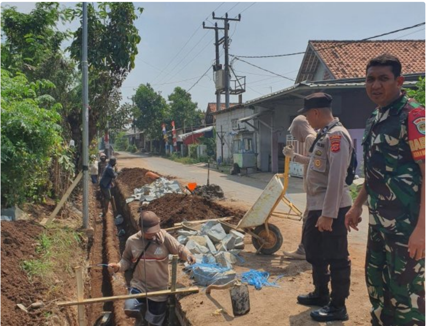
Bhabinkamtibmas Dan Babinsa Cek dan awasi Pembangunan Infrastruktur didesa binaannya
